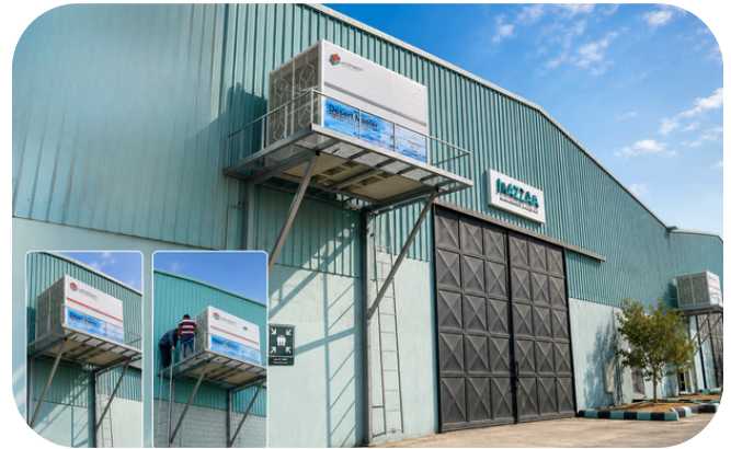
Project: Ajzaa Manufacture Factory Riyadh مصنع أجزاء للتصنيع - الرياض
